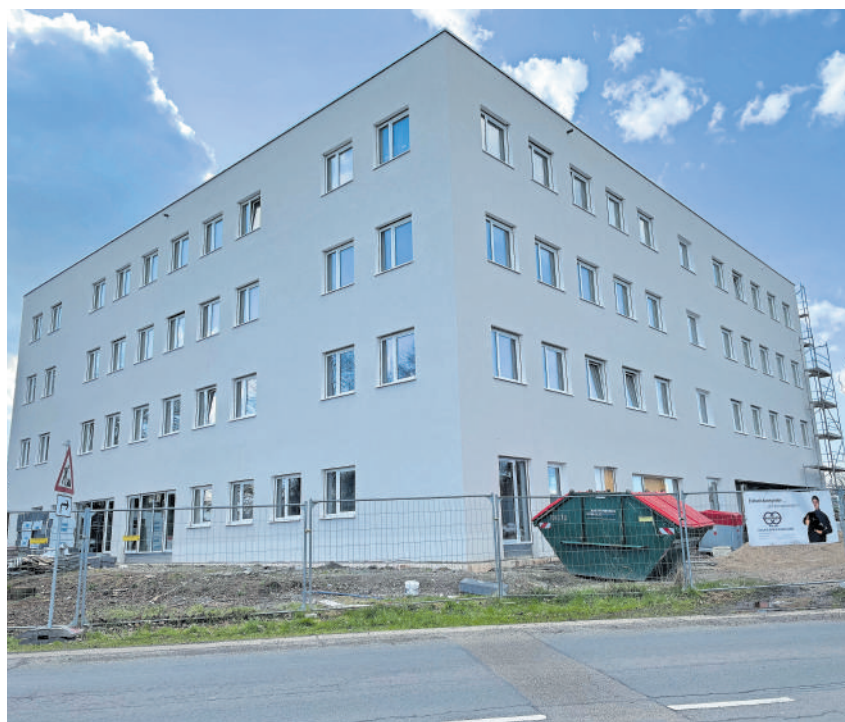
Die Baustelle: Noch in diesem Jahr soll das Ärztehaus in Großkrotzenburg eröffnet werden. Es ist mit seinen 3.500 Quadratmetern vermietbare Fläche das Flaggschiff des Spezialfonds UNUA. Rund 17 Millionen Euro werden hier investiert.
