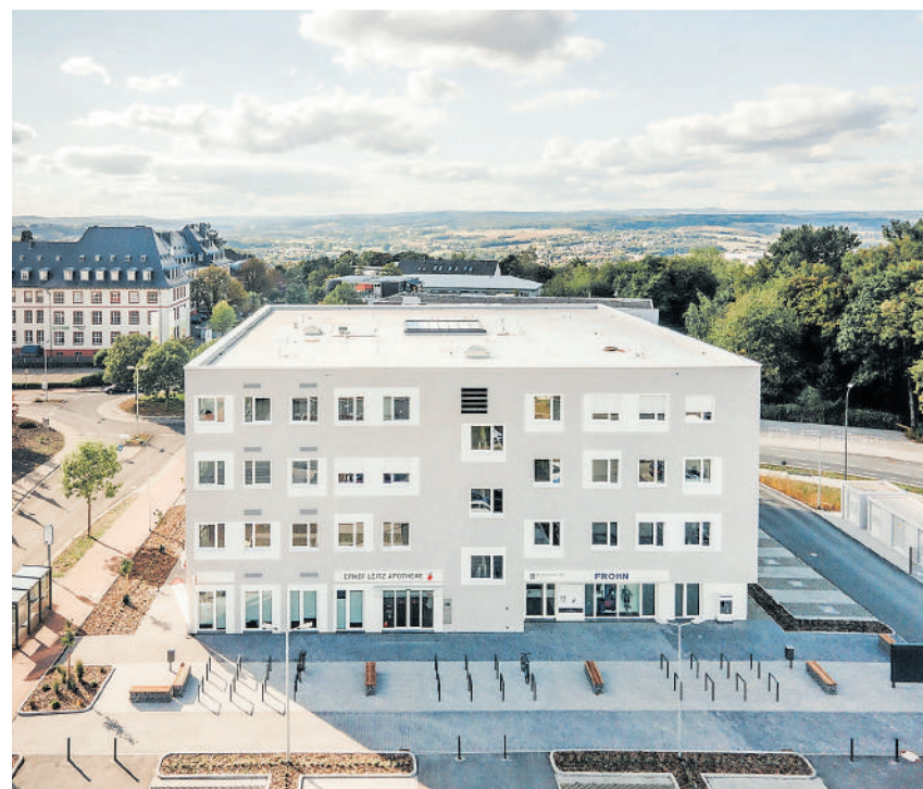
Das fertige Haus: Das MEDZENTRUM Spilburg in Wetzlar wurde im vergangenen Jahr eröffnet. Herzstück des Gebäudes mit 3.350 qm ist eine internistische Berufsausübungsgemeinschaft.
